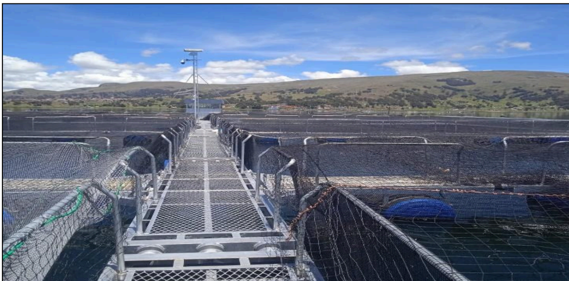
Figura 01: Diseño estructural de las jaulas flotantes a base de acero galvanizado
