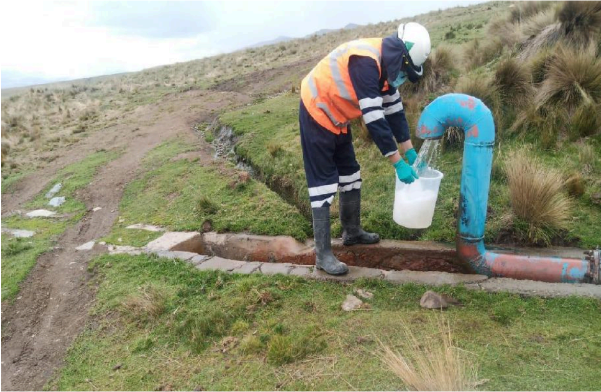
Figura 16: Afluente de agua tratada.
