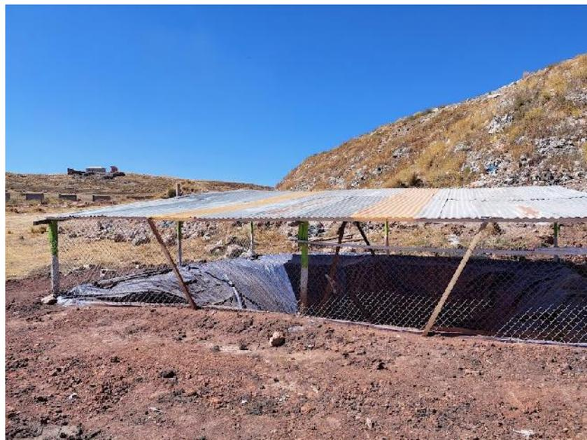
**Figura 30:** Pozo de acumulación de lixiviados.
