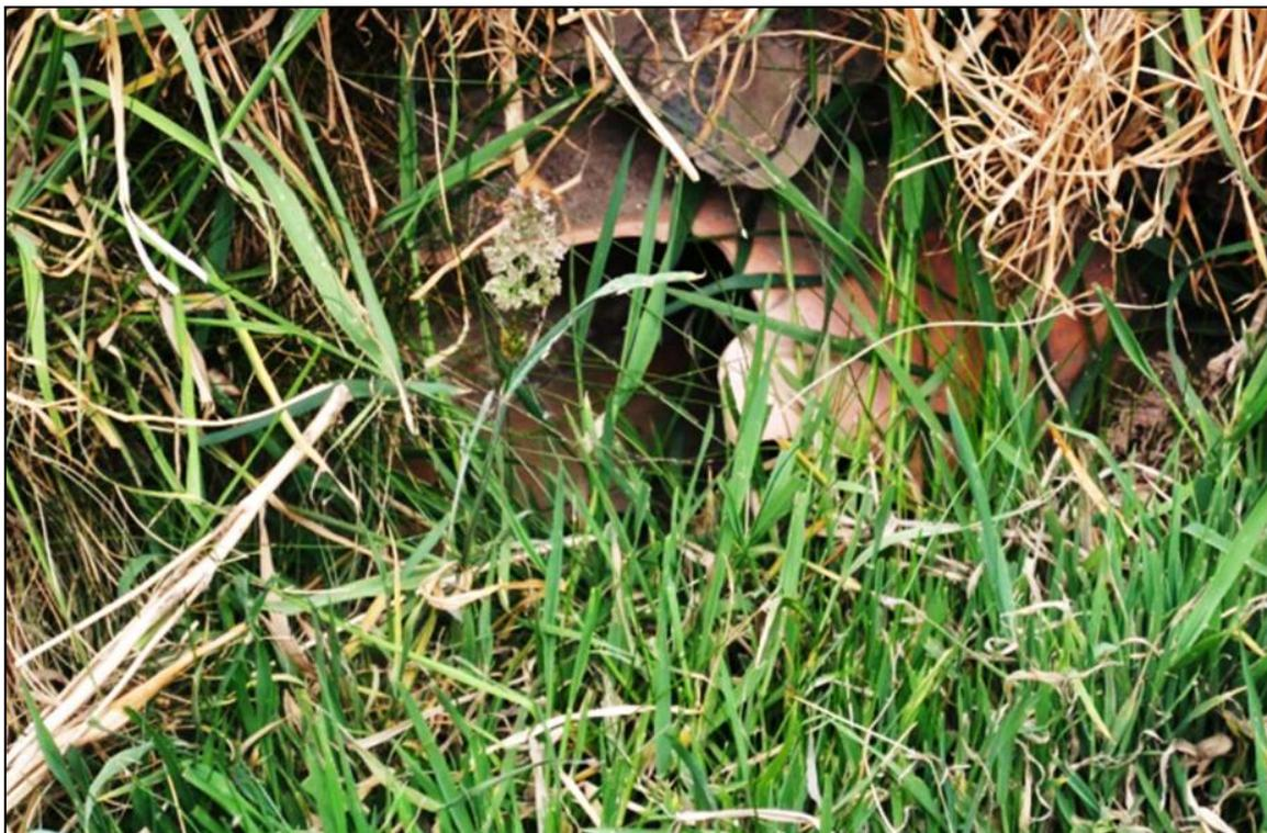
**Figura 12:** Conexión de desagüe clandestino para drenar agua residual doméstica
