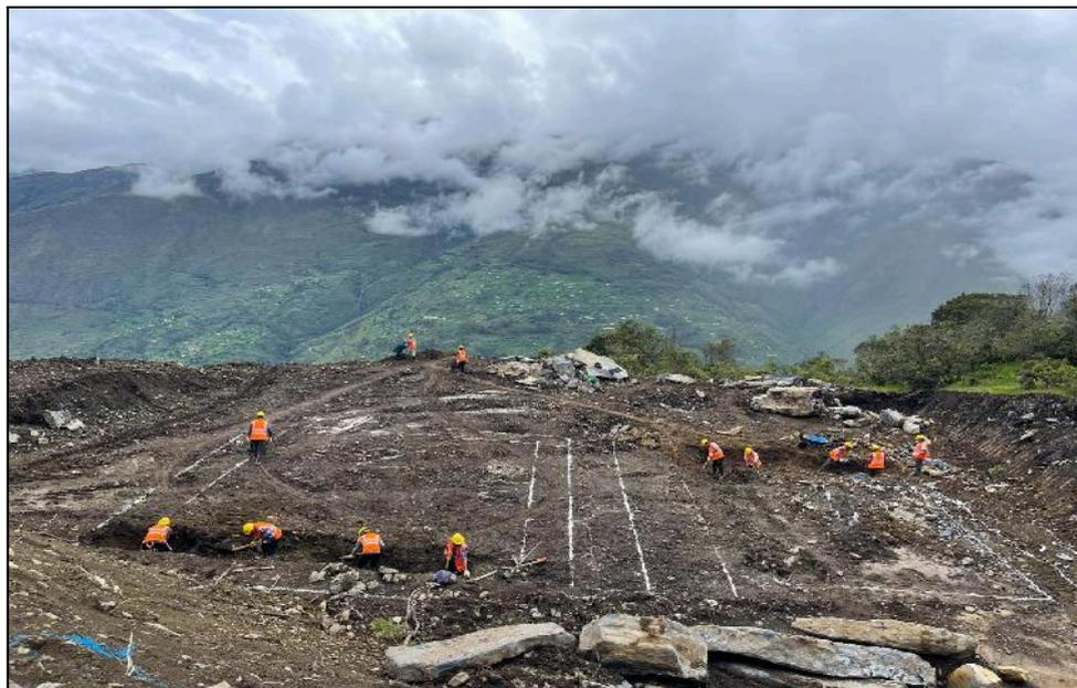
**Figura 08:** Vista panorámica de los trabajos de excavación para las zapatas del reservorio.
