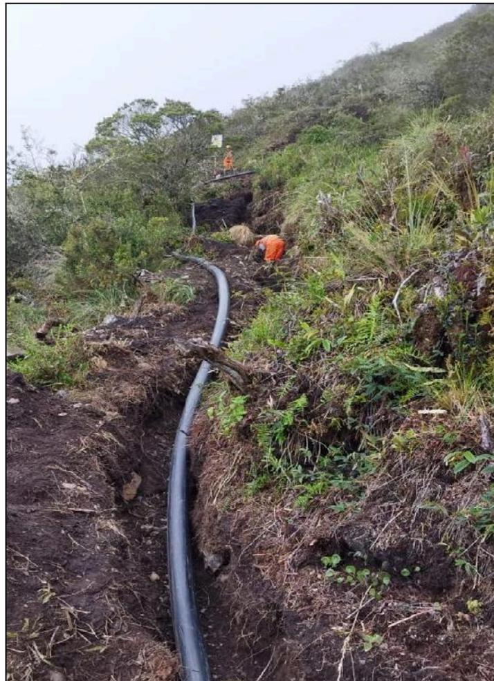
**Figura 11:** Implementación de las tuberías HDPE para la red de conducción de agua.
