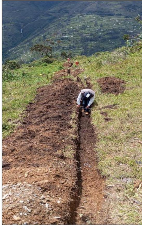
**Figura 12:** Revisión de las dimensiones de las zanjas para las tuberías.
