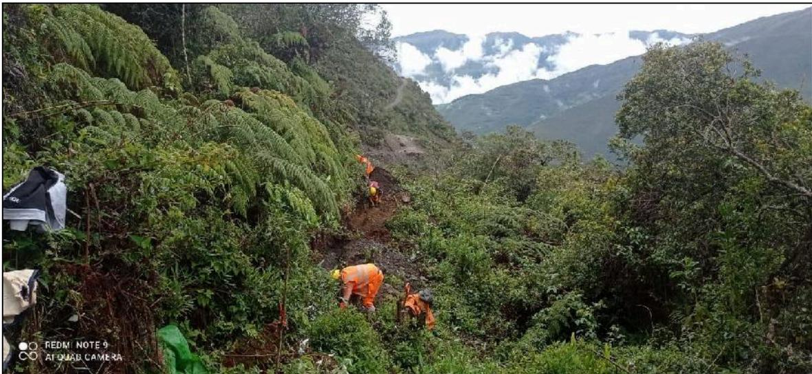
**Figura 10:** Excavación para la red de conducción en el terreno natural.
