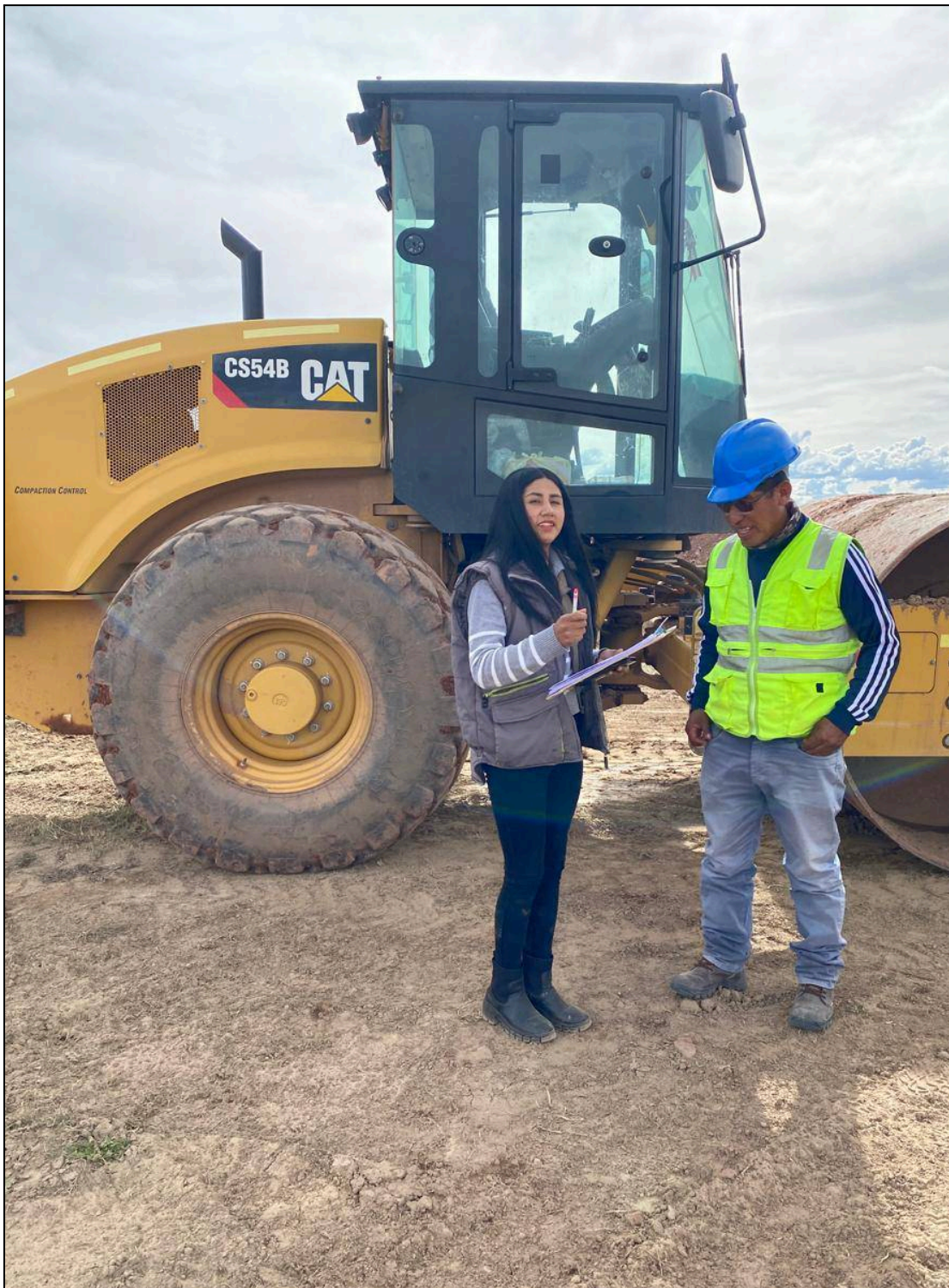
Figura 10 Aplicación del instrumento durante las actividades de campo.
