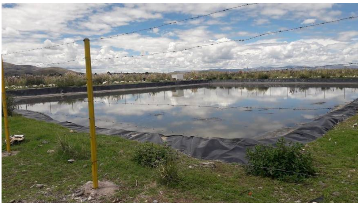
Figura. 01. LAGUNA DE OXIDACIÓN DEL DISTRITO DE CABANILLA
