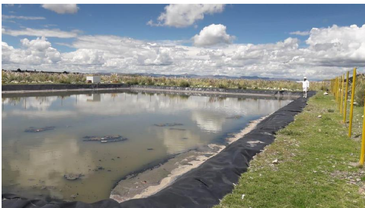
Figura. 02. LAGUNA DE OXIDACIÓN DEL DISTRITO DE CABANILLA SEÑALANDO LA SALIDA HACIA EL RÍO
