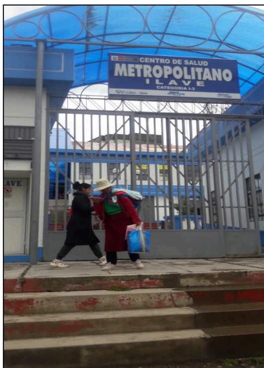
Figura 03: Instalaciones del metropolitano llave
