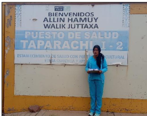
Figura 05: Puesto de Salud Taparachi I-2 (Exterior)
