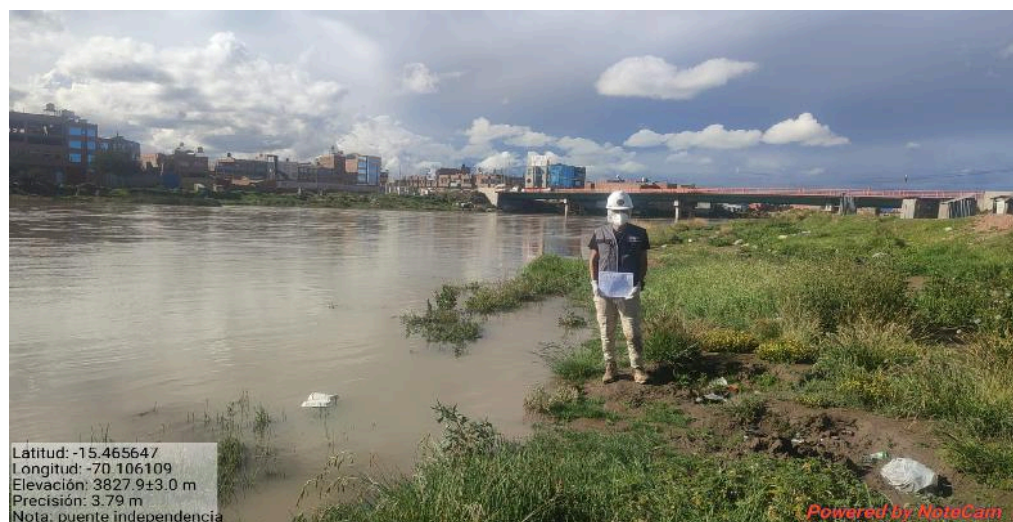
Figura 02: Vista General de la Zona de Estudio (Puente Independencia)
