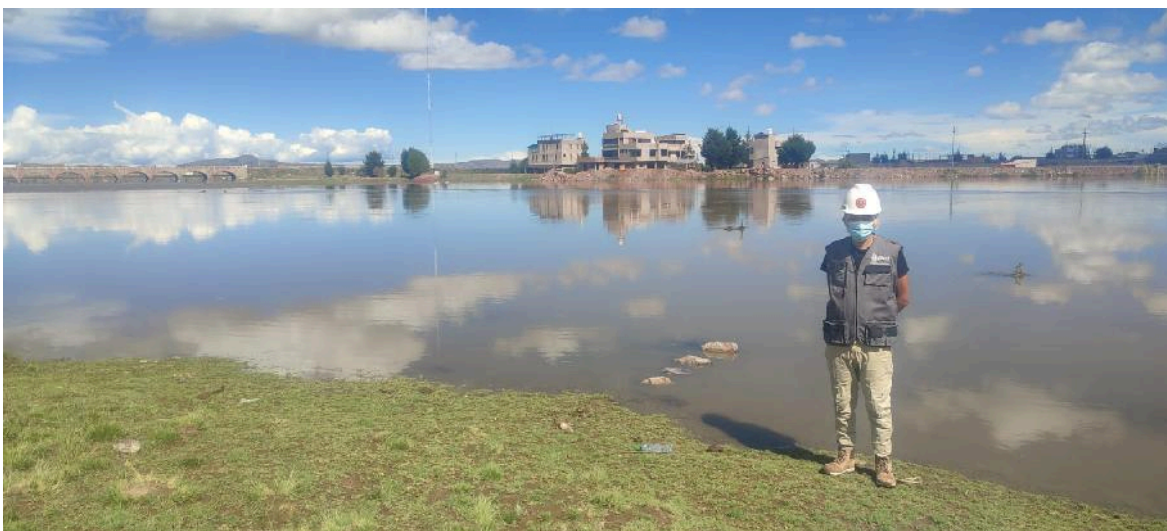
Figura 04: Vista General de la Zona de Estudio ( Puente Rio Maravillas)
