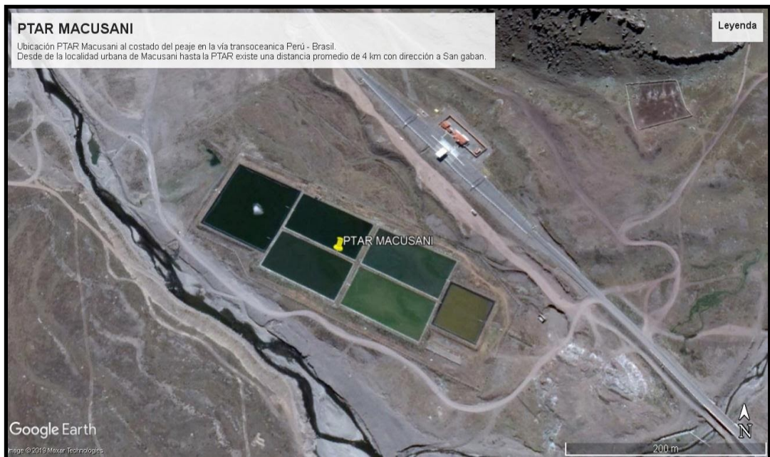
Figura 3: Vista Satelital de la PTAR de Macusani
