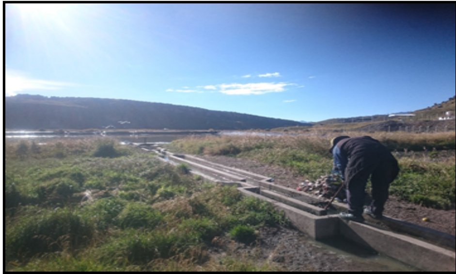
Figura 27: Limpieza de las rejillas de la PTAR con el uso de un rastrillo manual.
