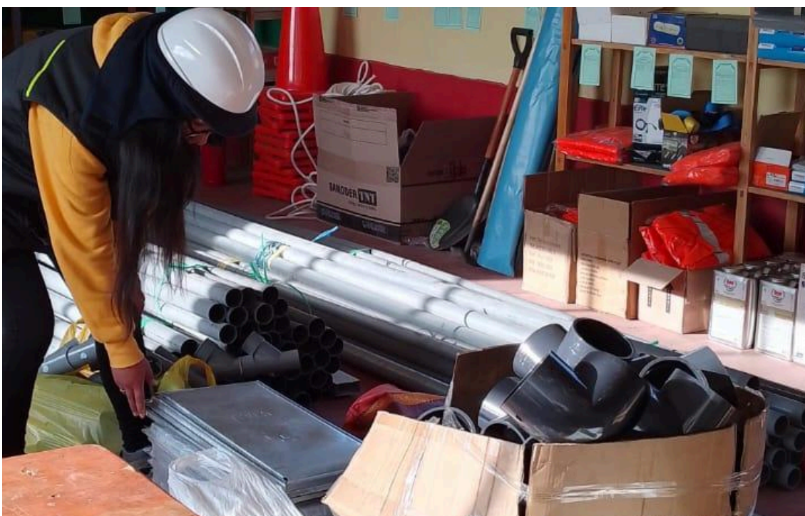
Fotografía 03: Almacén de Obra.
