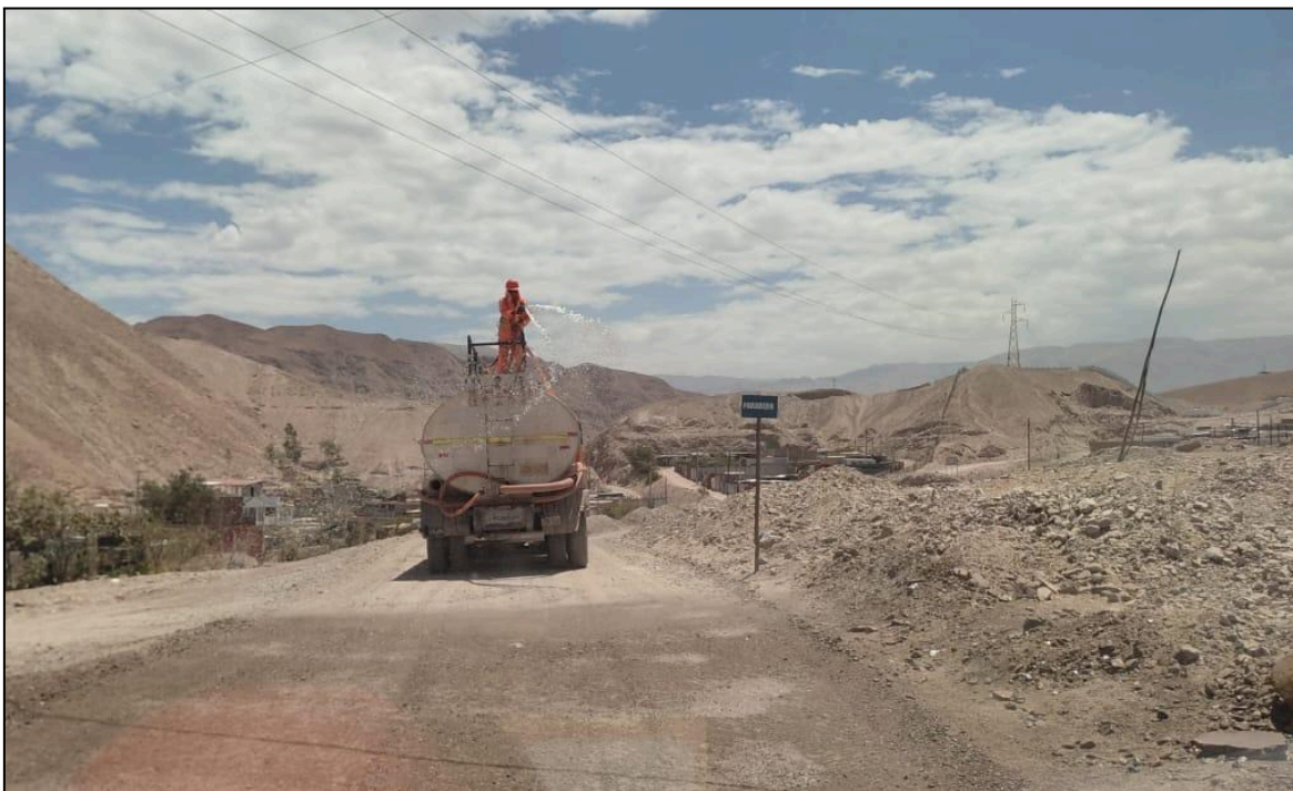
Figura 09: Riego con camión cisterna
