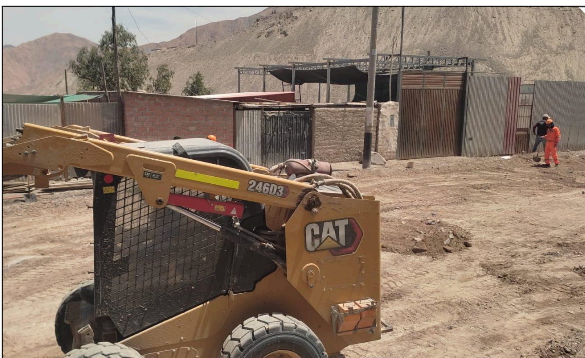
Figura 12: Riego con camión cisterna
