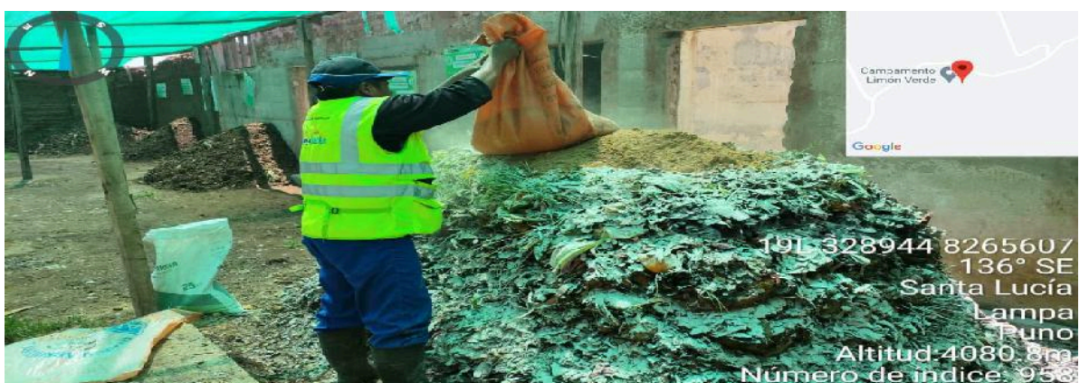
Figura 21: Armado de pilas de compostaje (adición de aserrín).
