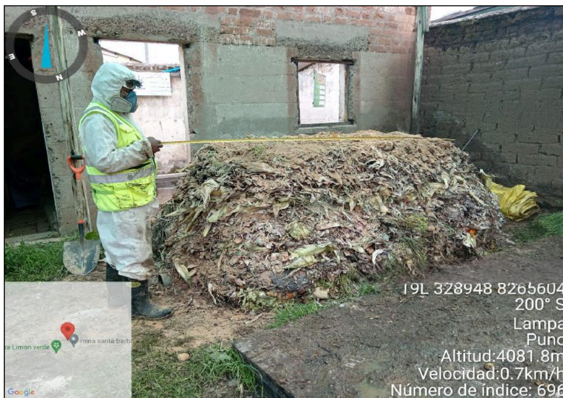
Figura 06: Armado final de las pilas de compostaje aerobio.
