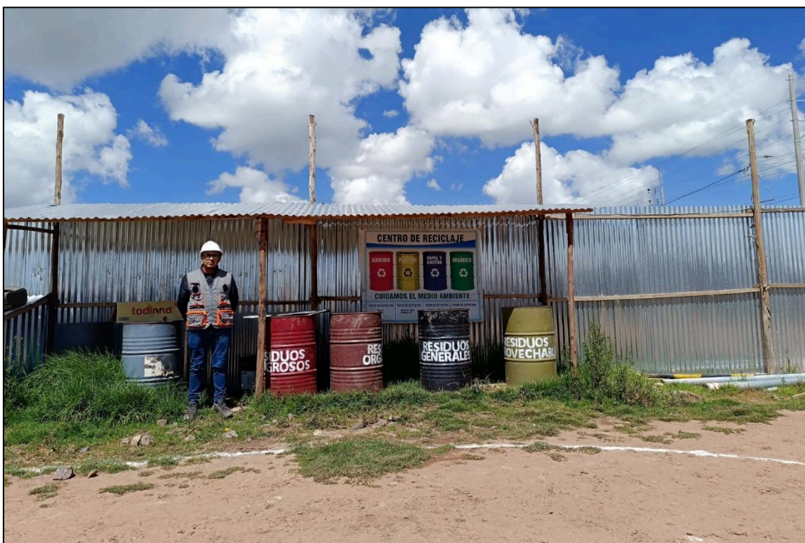
Figura 21: Verificación de almacenamiento de residuos sólidos de obra.
