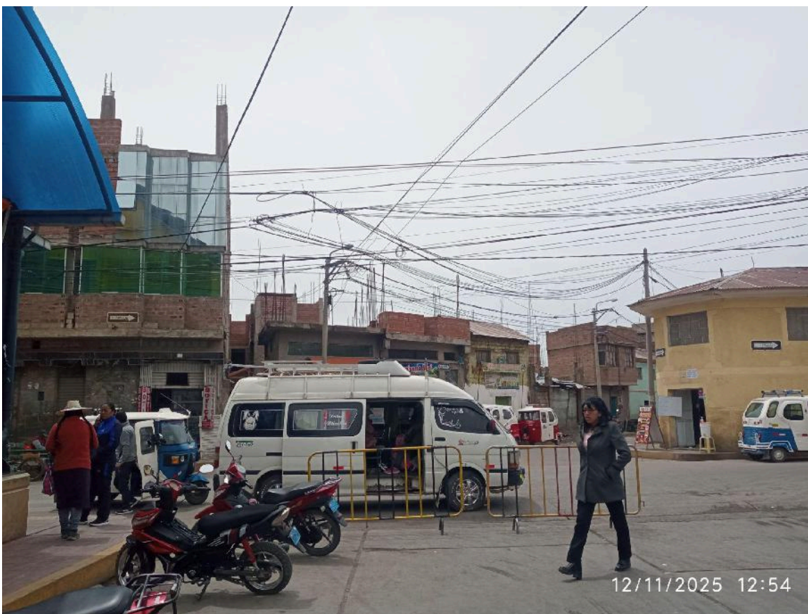
Figura 17: Percibimos el cableado y algunos vehículos motorizados lo cual genera incomodidad en el Jr, Atahualpa. ( JR.ATAHUALPA 12/11/2025 )
