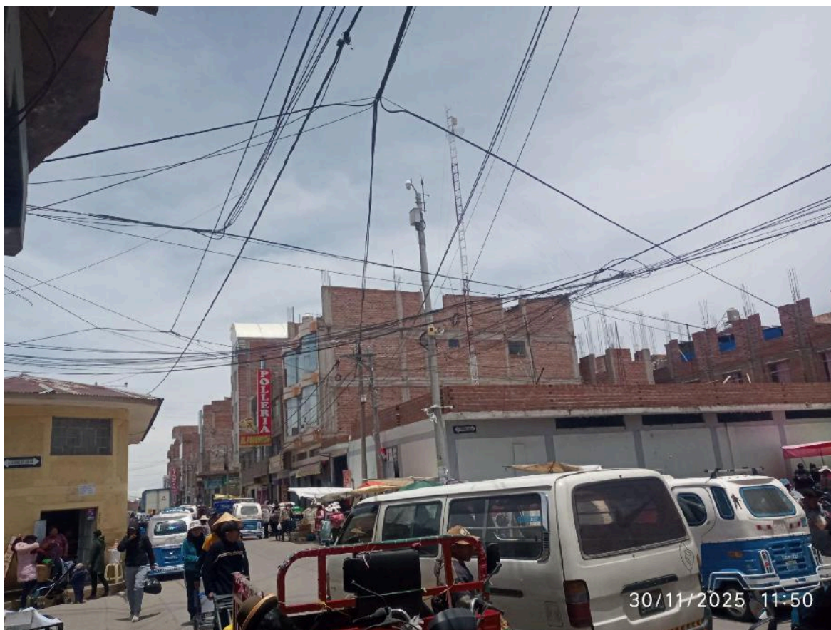
Figura 28: Vemos la excesiva cantidad de cables que pasan por todos lados el cual genera una especie de telaraña y esto ocasiona y trae efectos como el estrés en la población. ( JR. ATAHUALPA 30/11/2025 )
