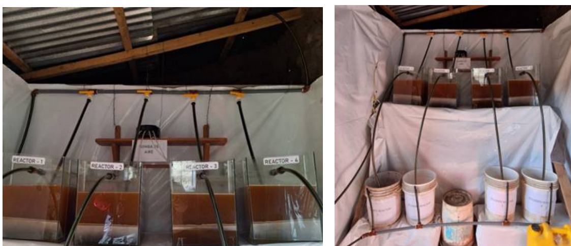
Figura 08: Efluente en sistema de tratamiento
