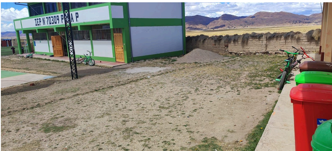
Figura 18: Vista panorámica de la ubicación de los contenedores de residuos sólidos en la IEP N° 70309.
