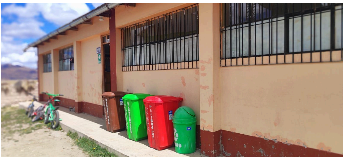
Figura 19: Vista panorámica de la ubicación de los contenedores de residuos sólidos en la IEP N° 70309.
