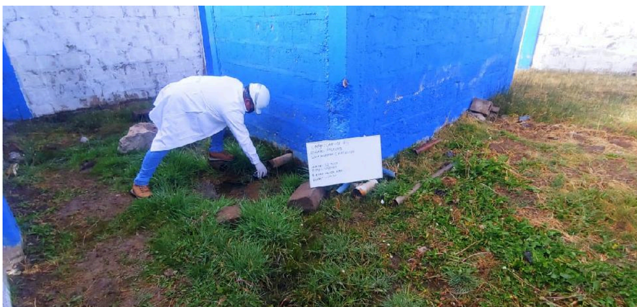
Figura 13: Captación de agua
