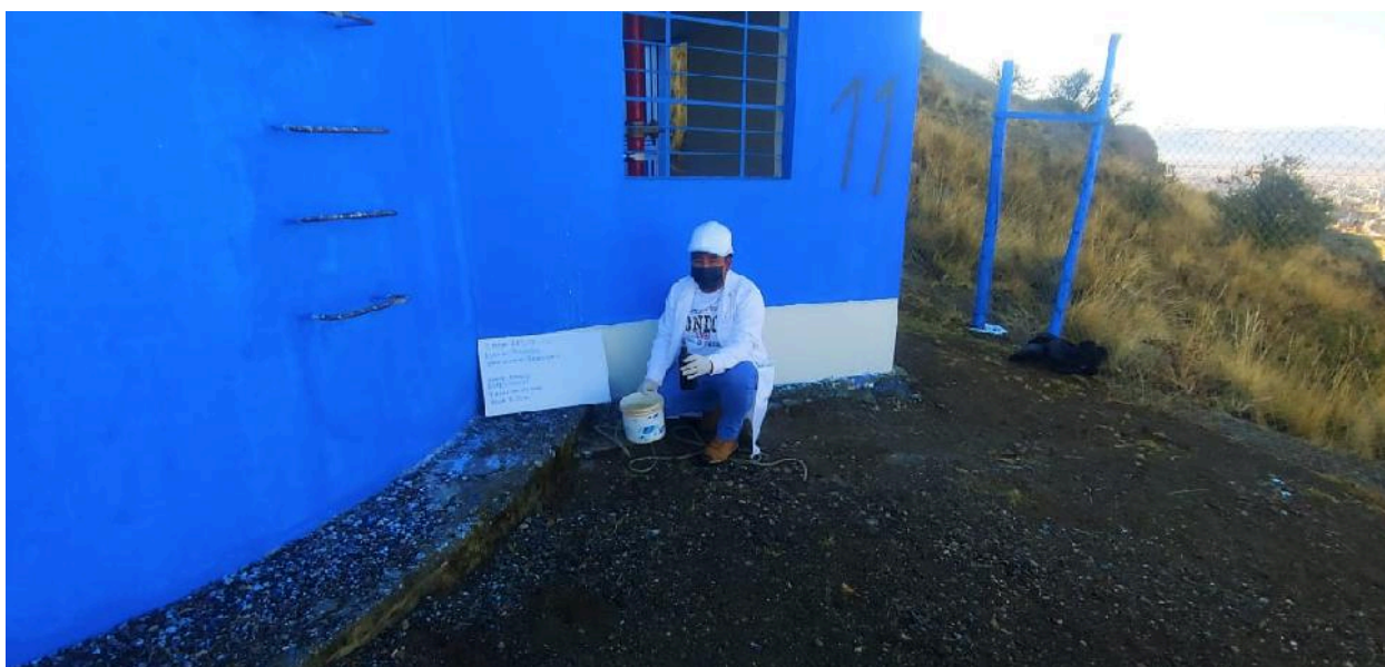
Figura 12: Toma de muestra de reservorio de Pilcuyo
