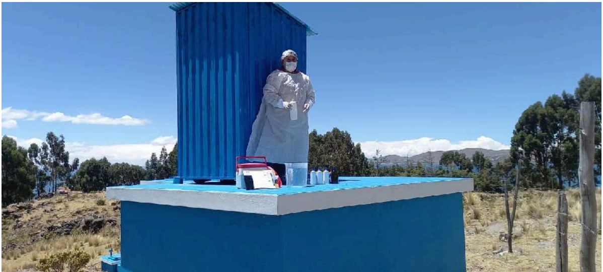
Figura 12: Vista panorama del Reservorio 03 - Karina.
