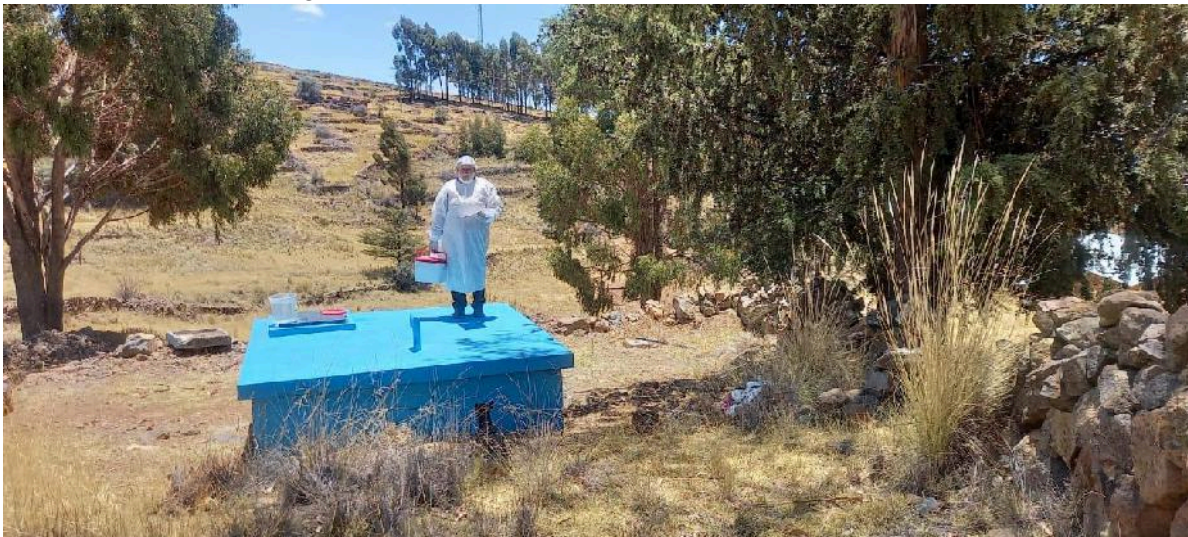
Figura 10: Vista panorámica del Reservorio 01 - Karina.
