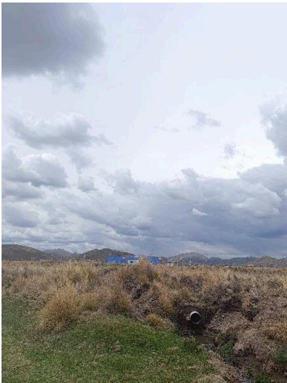
Figura 11: Fotografía panorámica del punto del lugar del vertimiento de aguas residuales.
