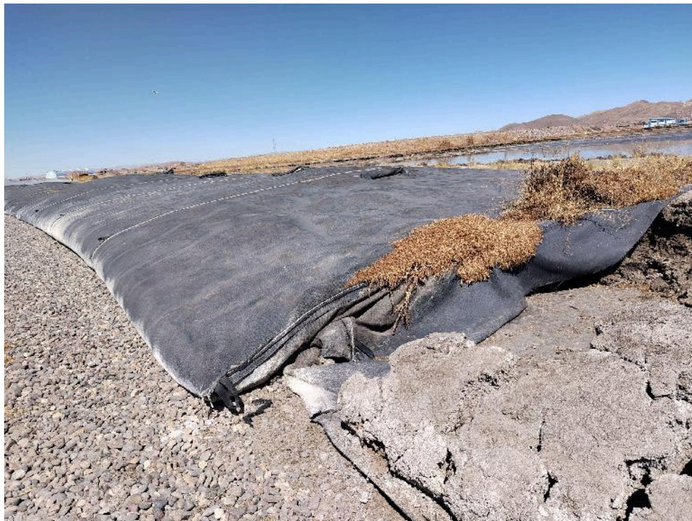
IMAGEN 1. Lodo residual cubierto con geomembrana en la PTAR-SEDAJULIACA.
