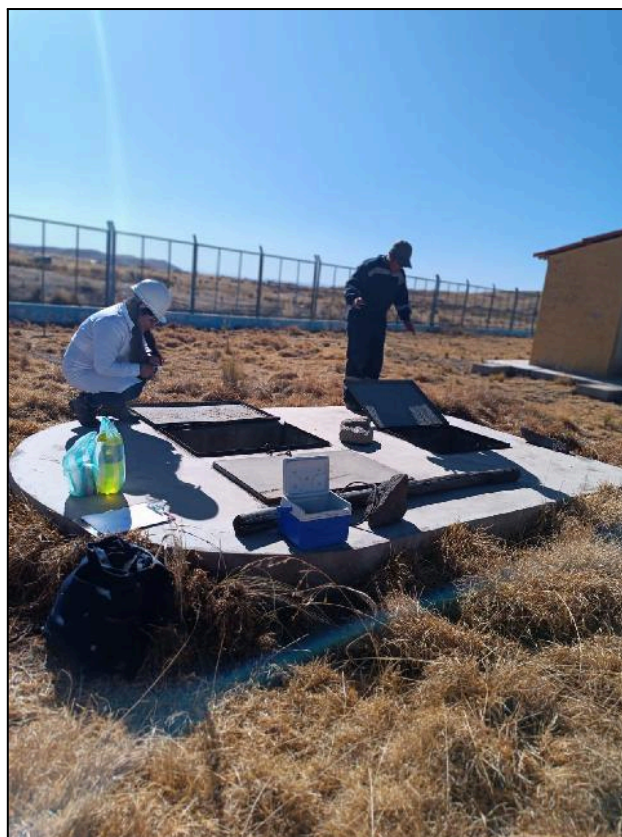
Figura 12: Personal de la PTAR apoyando en la identificación del punto de afluente
