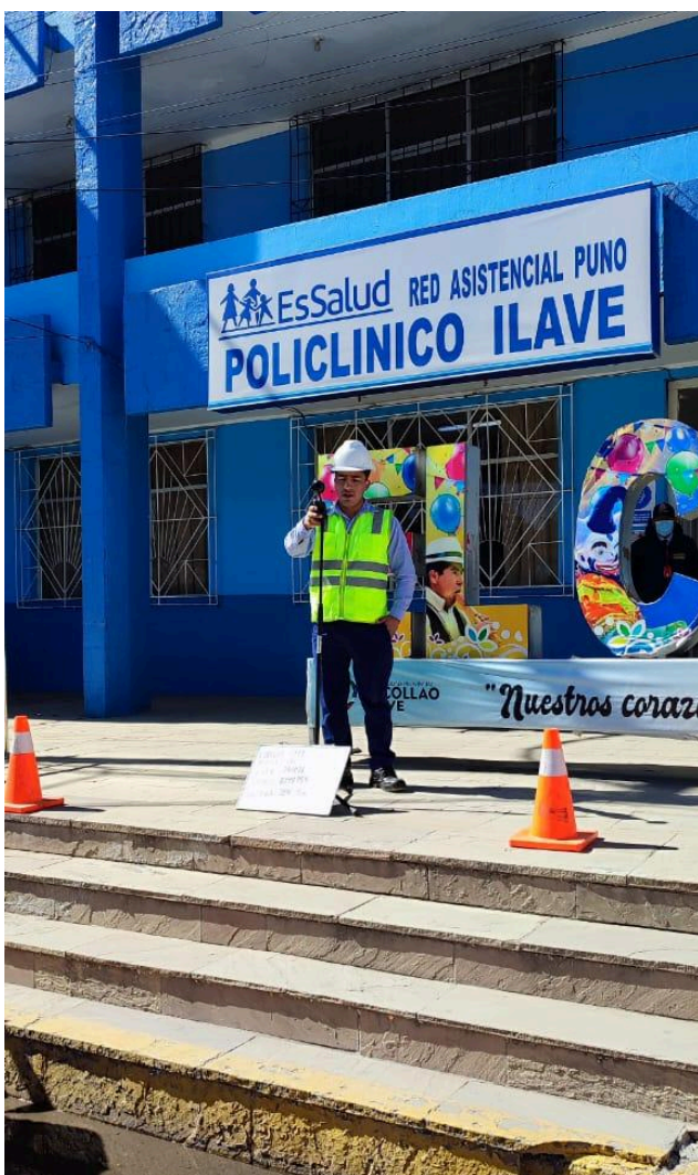
Figura 12: Instalación de los equipos en el Policlínico Ilave - EsSalud.
