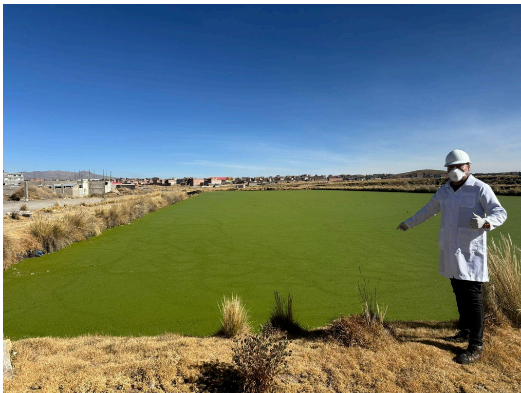
Figura 03: Vista general de las aguas residuales en la ciudad de Ilave.
