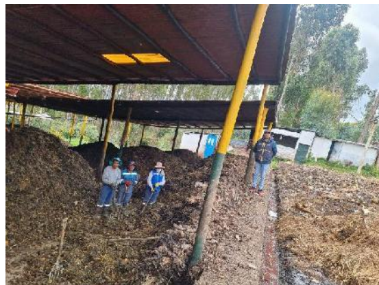
Preparados para la limpieza de la losa, para recibir el material del primer proceso de descomposición.
