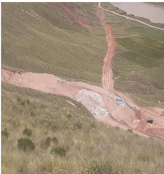
Figura 01: Vista de todo el botadero
