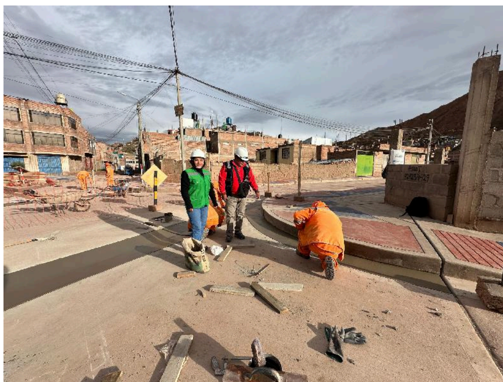
Figura 12: Inspección de áreas de trabajo
