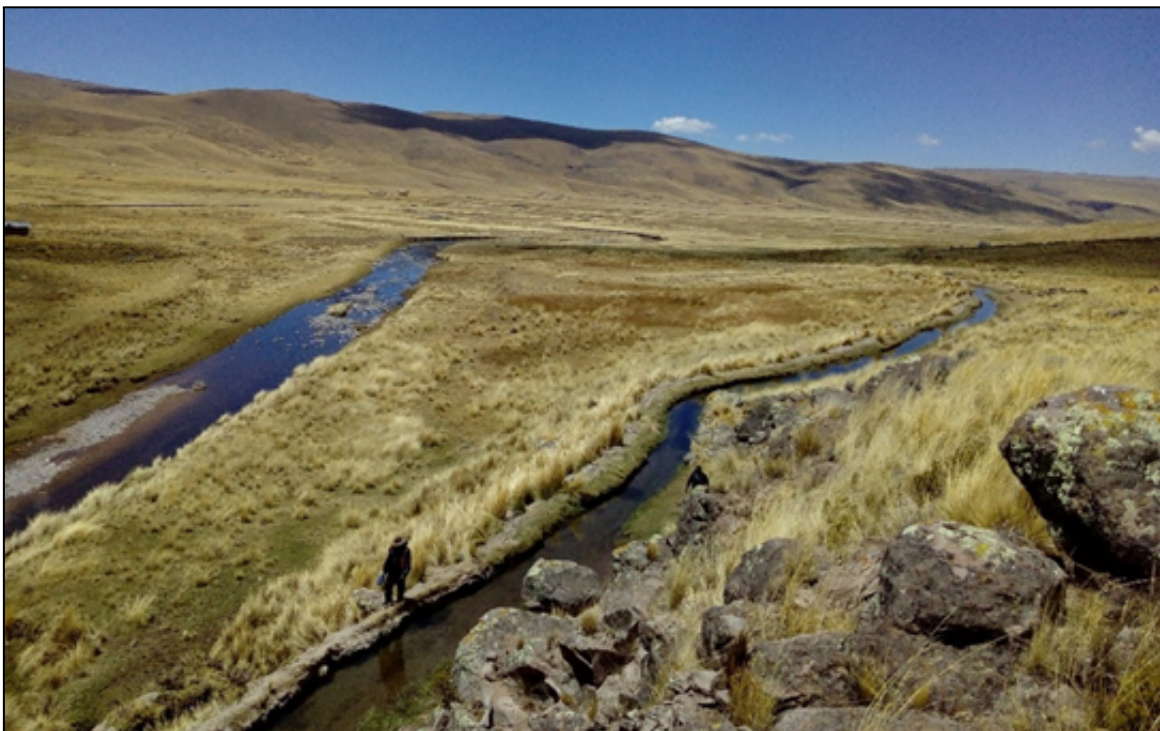
Figura 12: Características típica del terreno de la obra.
