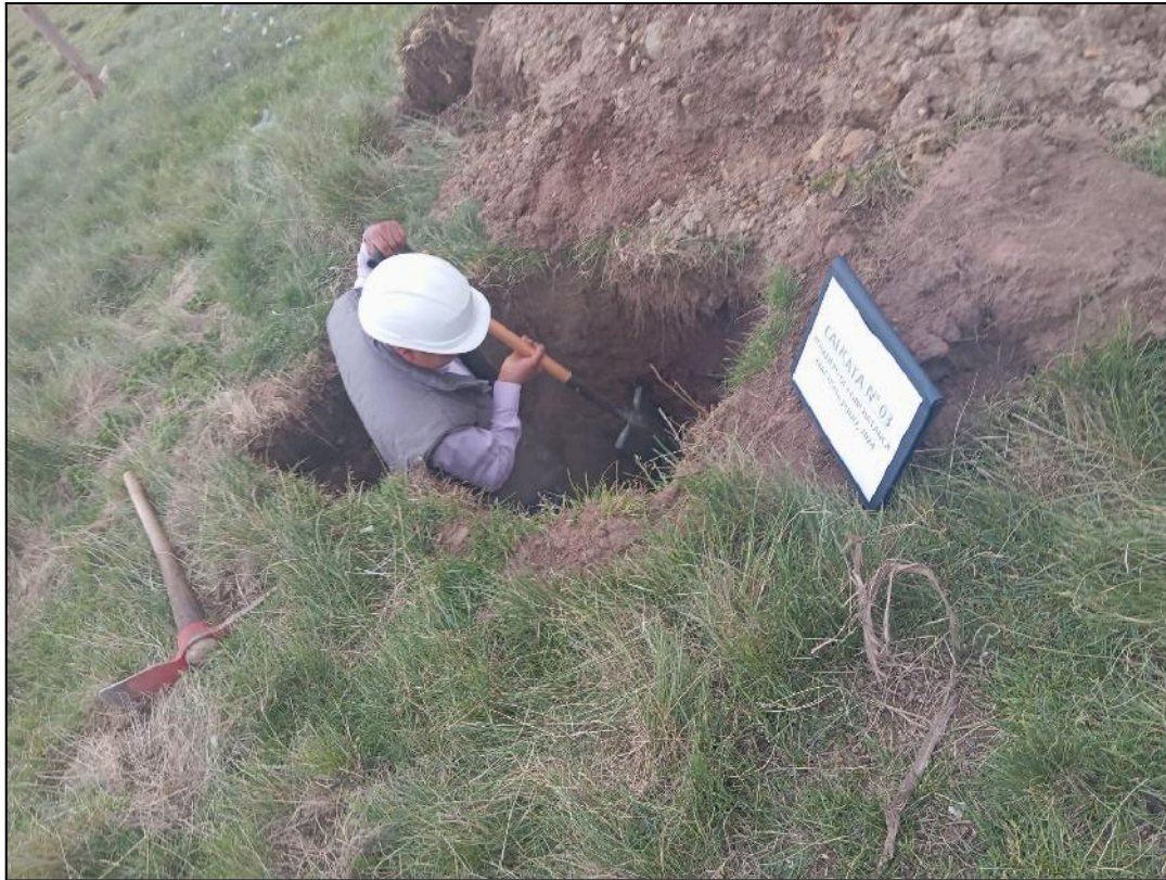
Figura 18: Proceso de excavación de calicatas
