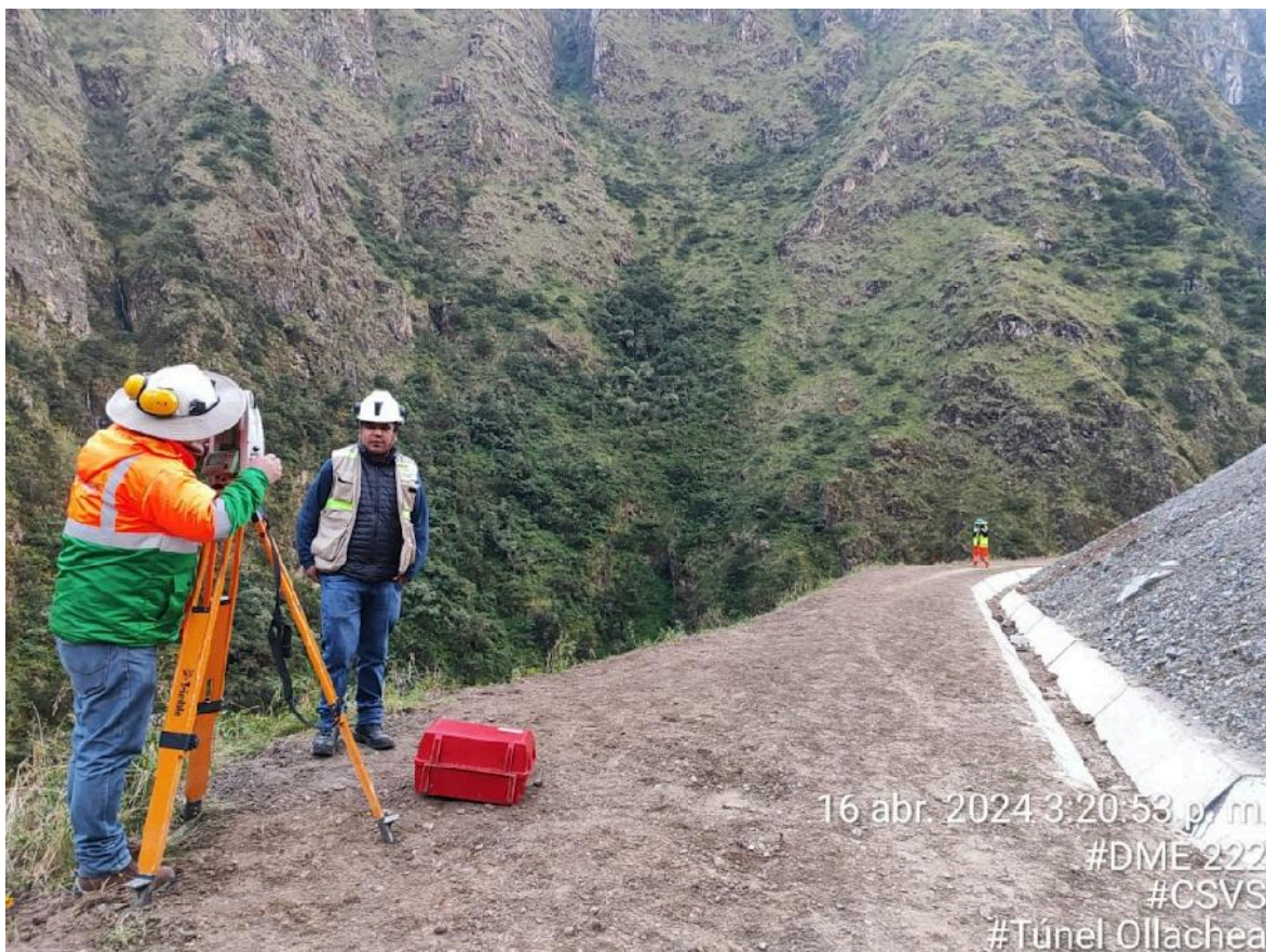
Foto 05: Monitoreo topográfico del DME
