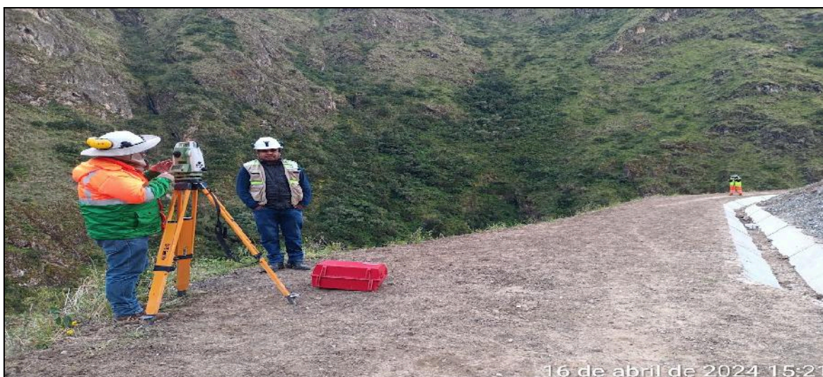
Figura 08: Monitoreo de taludes con equipo topográfico
