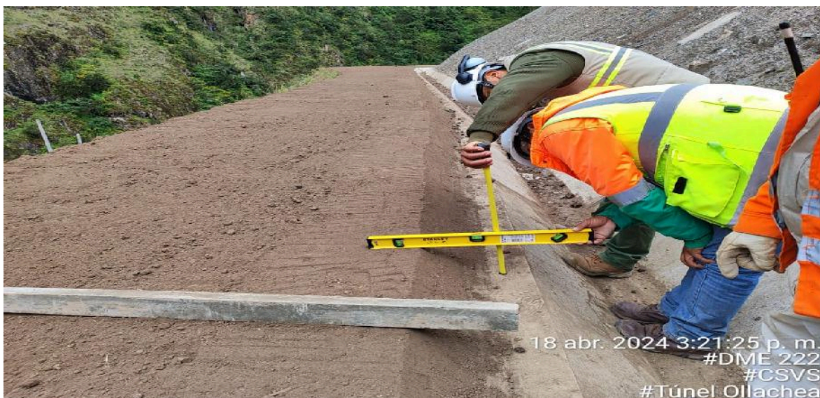
Foto 08: Material de top soil en DME
