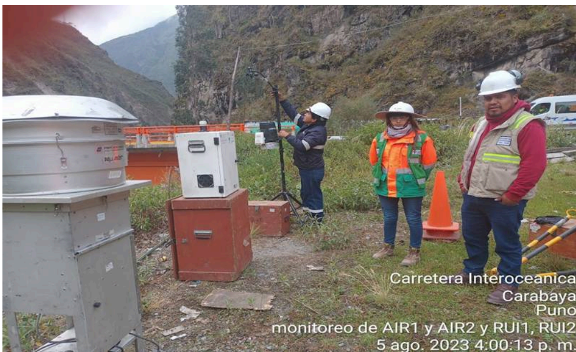
Foto 03: Instalación de instrumentos de monitoreo
