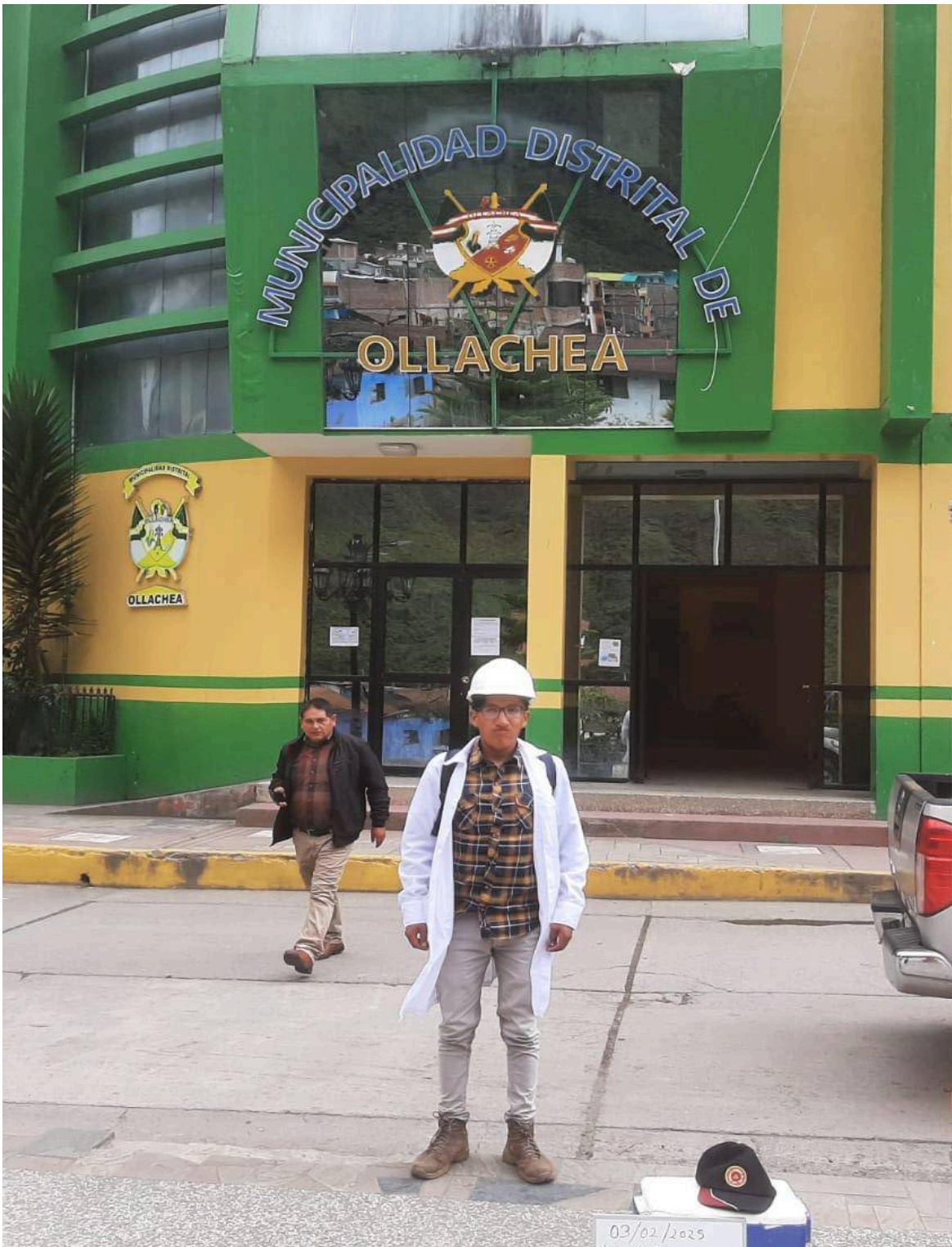
Anexo 14: Vista de la municipalidad distrital de Ollachea
