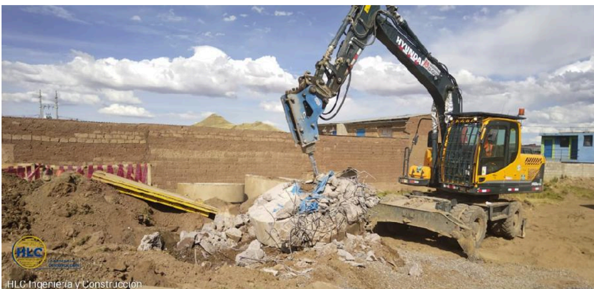
Figura 79: Accesorios de excavación para las retroexcavadoras CAT 420F. El picotón utilizado en labores de excavación de terreno rocoso y demolición de buzones retirados de funcionamiento emite niveles altos de ruido durante su uso.
