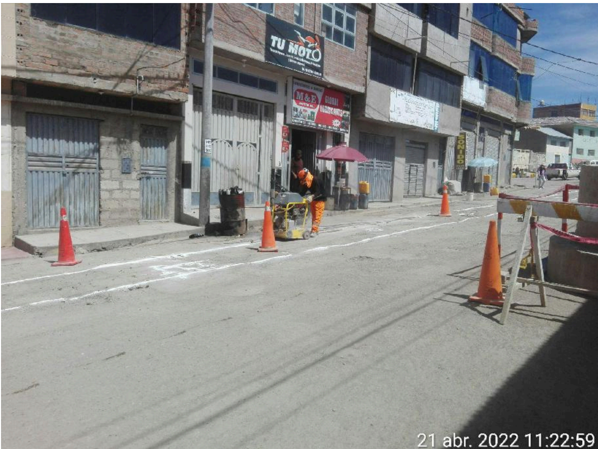
Figura 81: Operaciones de corte de asfalto rígido, una de las actividades que más ruido produce.
