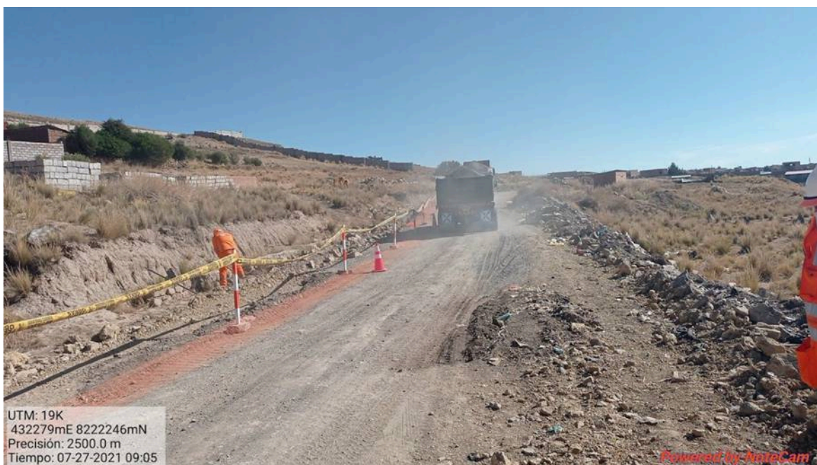
Figura 82: Traslado de desmote, material excedente o material de relleno, ocasionando emisión de material particulado.
