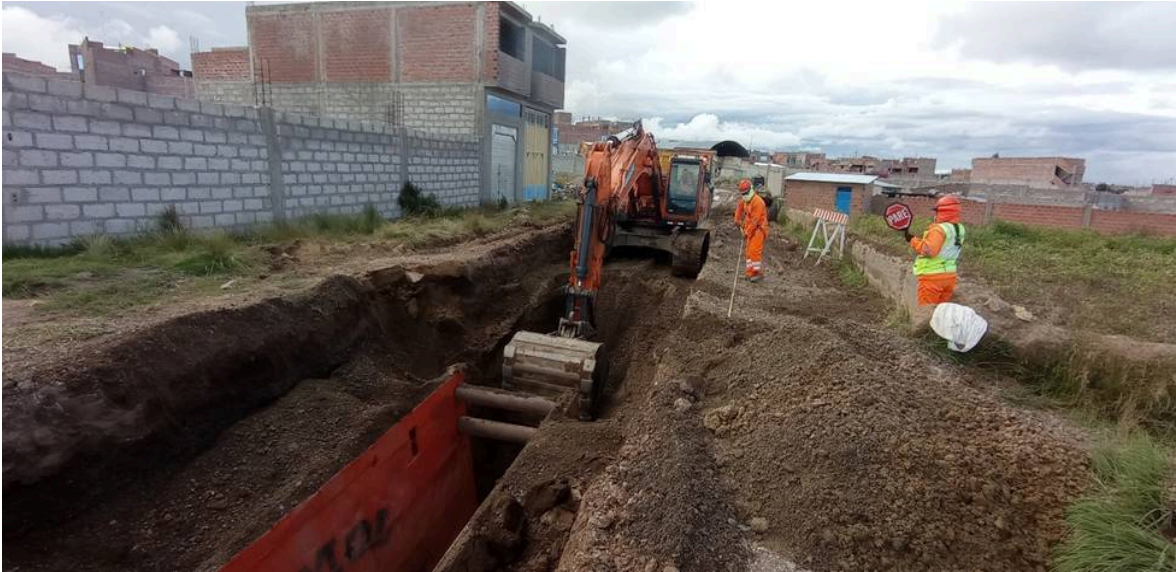
Figura 80: Actividades de excavación, fuentes de emisión de ruido.
