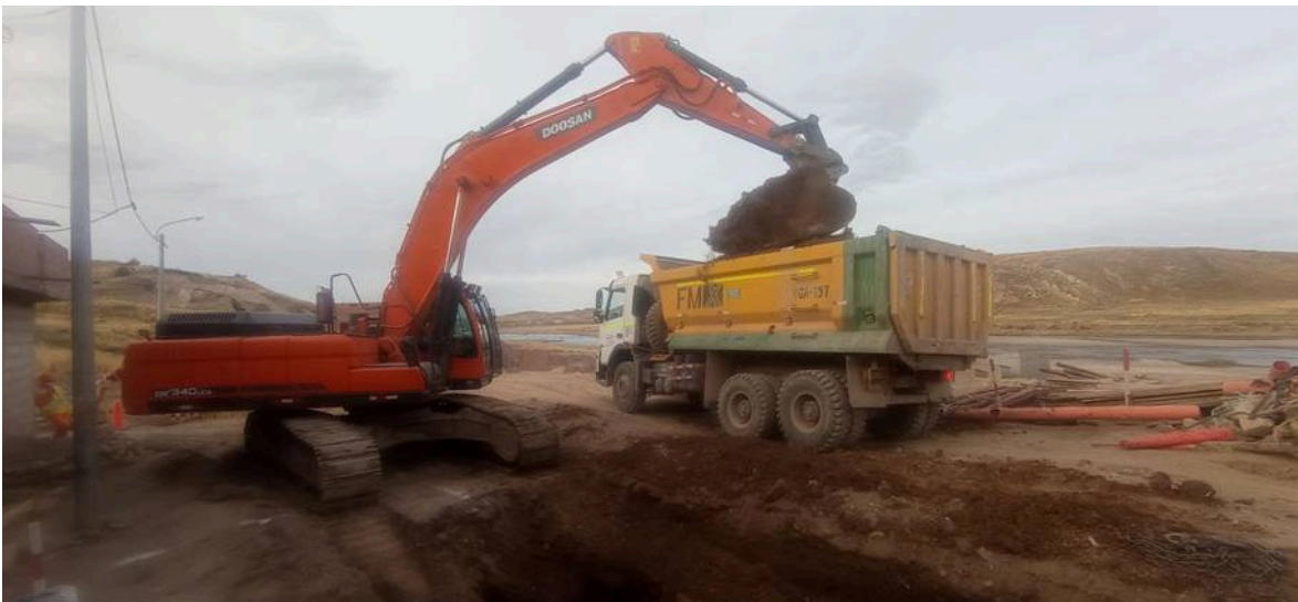
Figura 85: Excavación de zanjas
