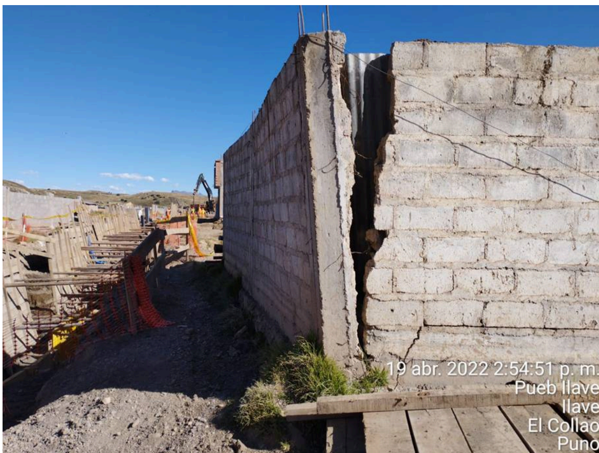
Figura 100: Propiedad de vecino afectada por la excavación y tránsito de vehículos, ocasionando malestar social.
