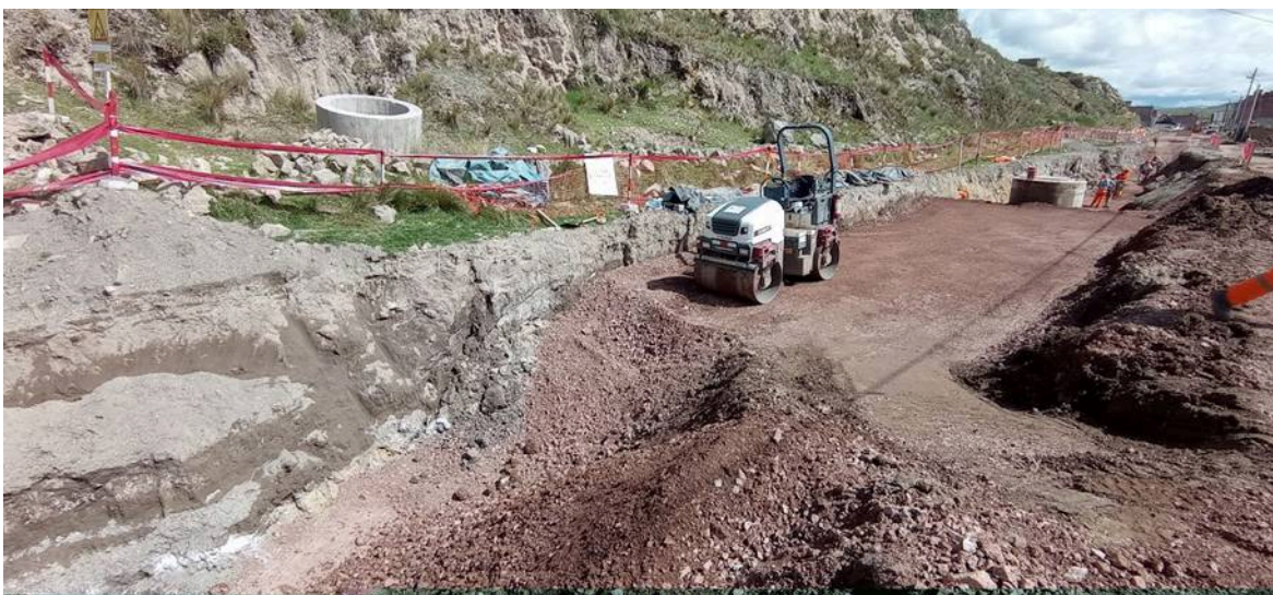
Figura 78: Actividades de relleno y compactación de suelos (frente AD03) haciendo uso de rodillo compactador tipo tándem de 2,6 t cuya operación implica emisiones elevadas de ruido.
