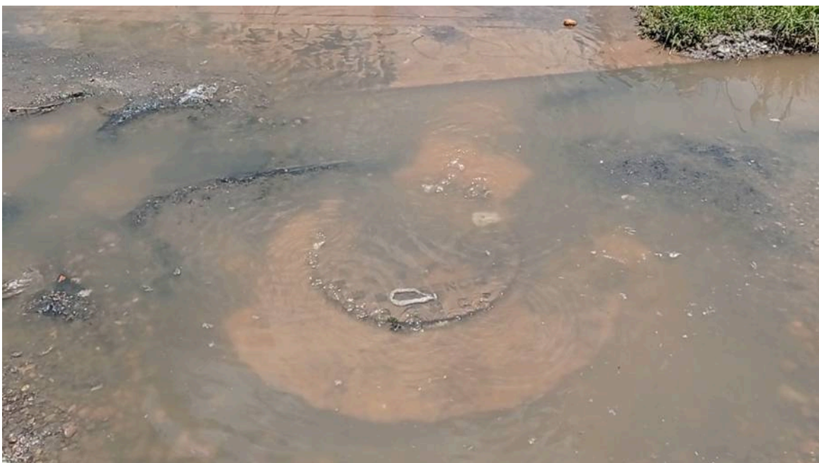
Figura 110: Colapso de buzones antiguos por antigüedad, falta de capacidad y falta de mantenimiento.
