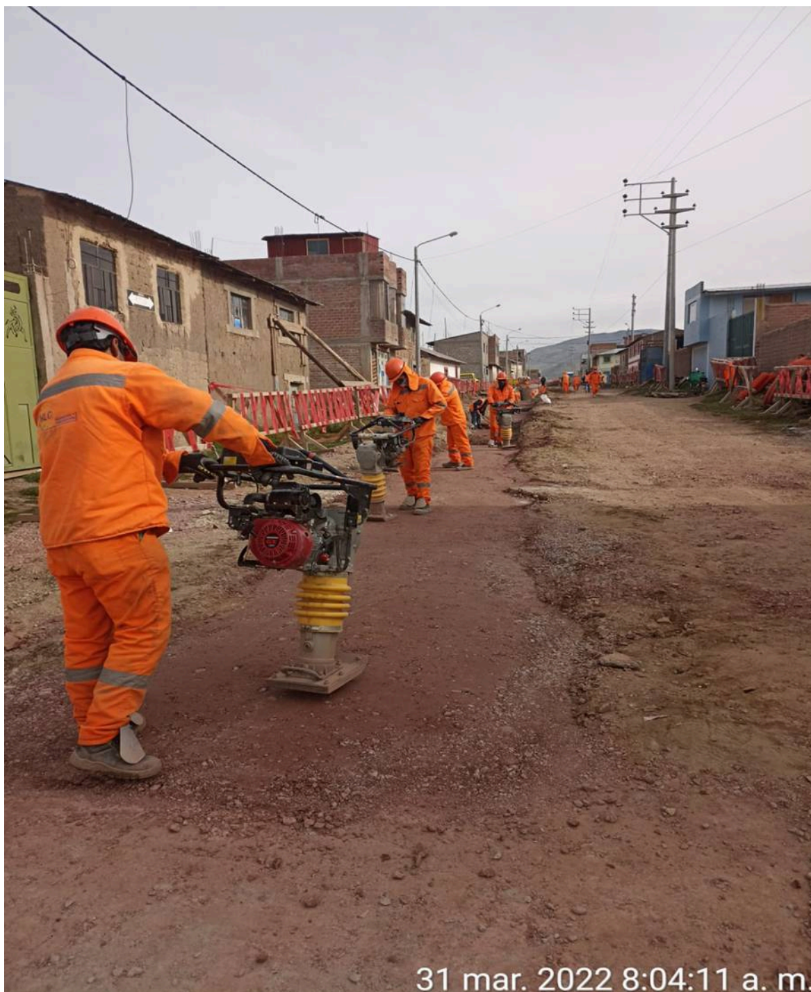
Figura 77: Trabajos de relleno y compactación de suelos (frente AD03) haciendo uso de vibroapisonadores tipo canguro, los cuales emiten altos niveles de ruido durante su operación.
