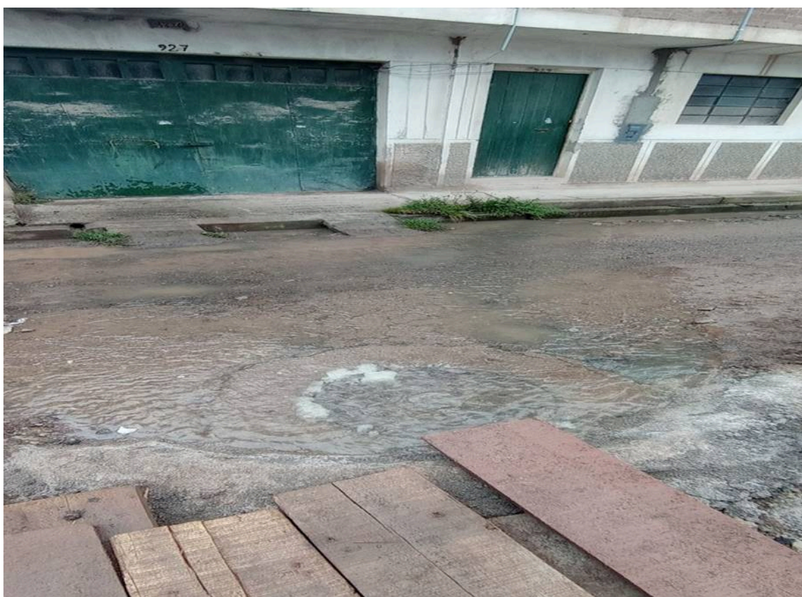
Figura 109: Estado de la red de desagüe de la ciudad de llave antes de la ejecución de las obras.
