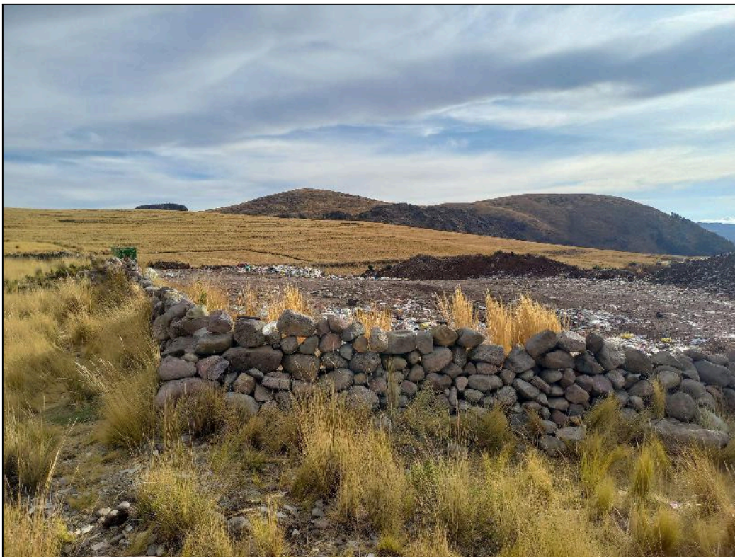
Figura 05: Cerco perimetral del botadero del distrito de Juli.
