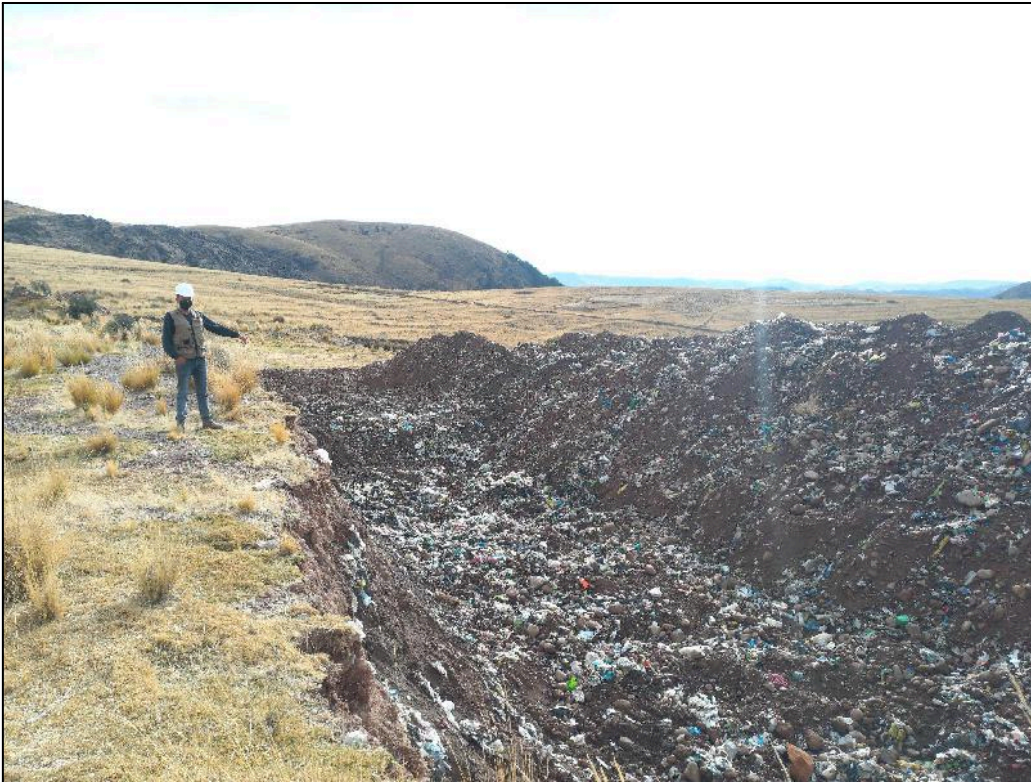
Figura 06: Celdas para la disposición final de residuos sólidos.
