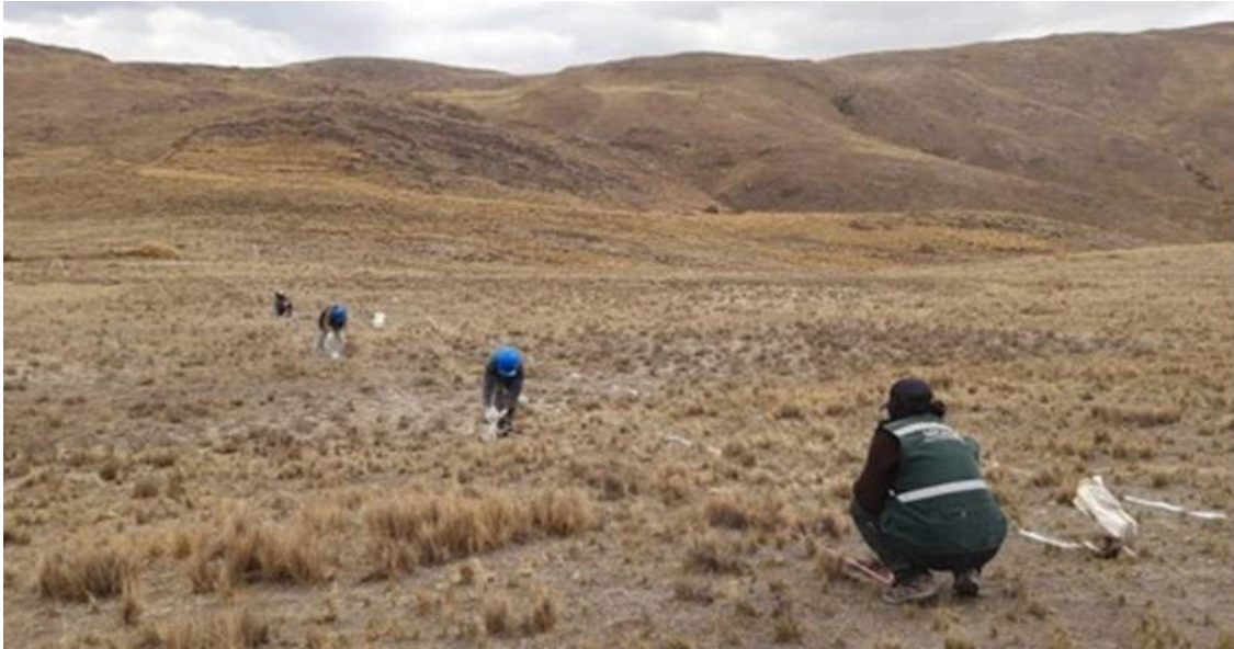
Vista N° 03: Afectación a la calidad del aire por levantamiento de polvos (trazo y replanteo inicial del dique).
