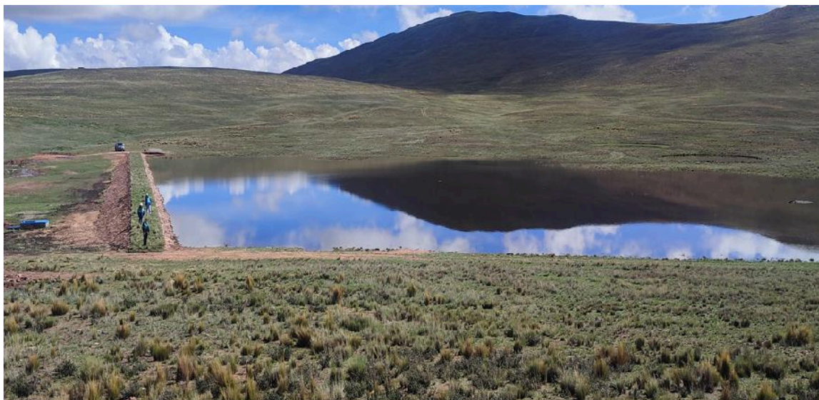
Vista N° 02: Etapa de operación del proyecto reparación de qocha en la microcuena Checayane
