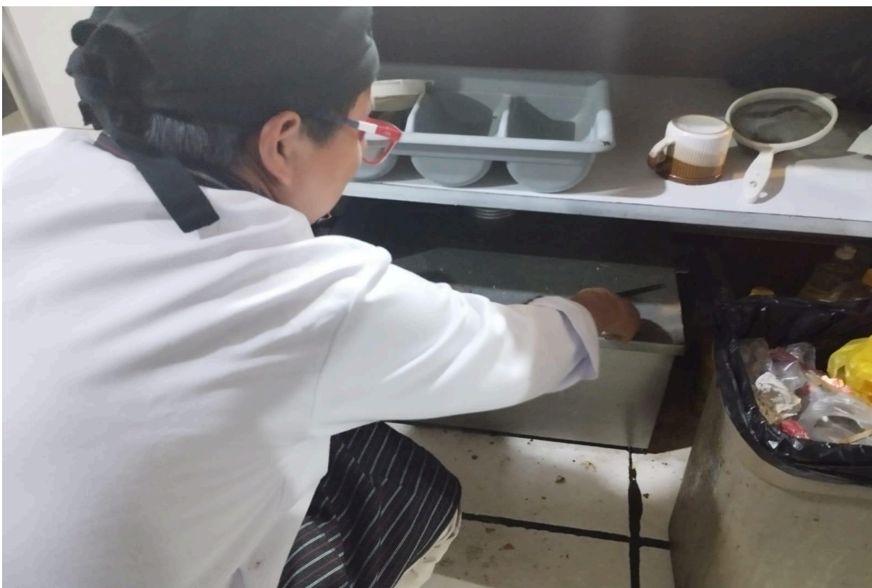
Fotografía 02. Difícil acceso y mantenimiento de trampas de grasas comerciales.
