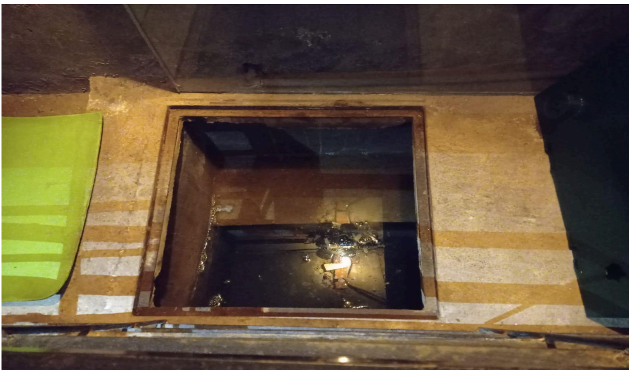
Fotografía 06. Trampa de grasa empotrada de restaurante pequeño, sin saturación.
