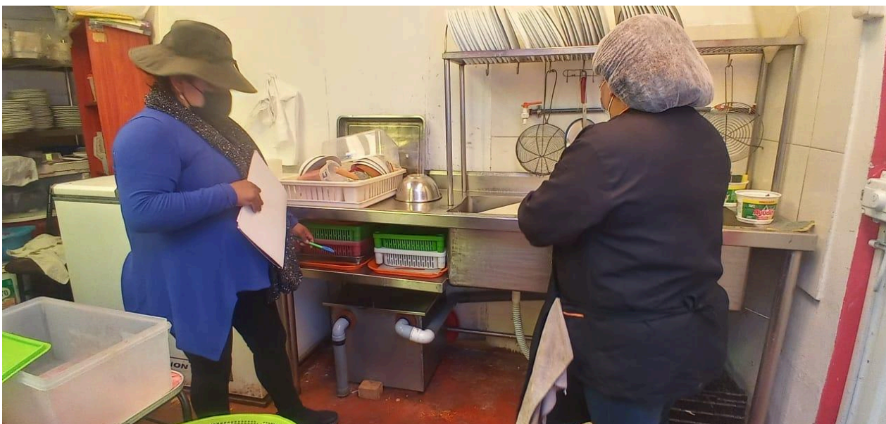
Fotografía 01. Aplicación de encuestas y verificación de trampas de grasa en restaurante.
