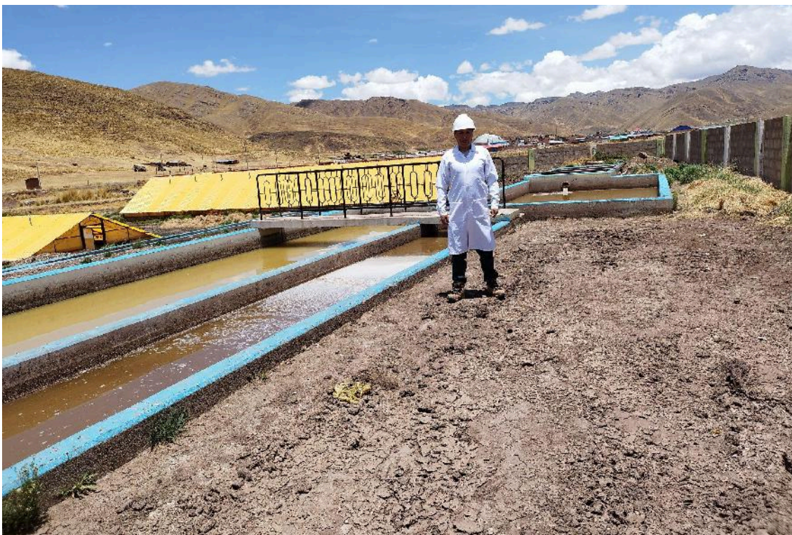
Figura 18. Vista de los desarenadores primario y secundario
