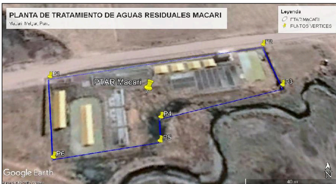
Figura 03. Ubicación de planta de tratamiento de aguas residuales
