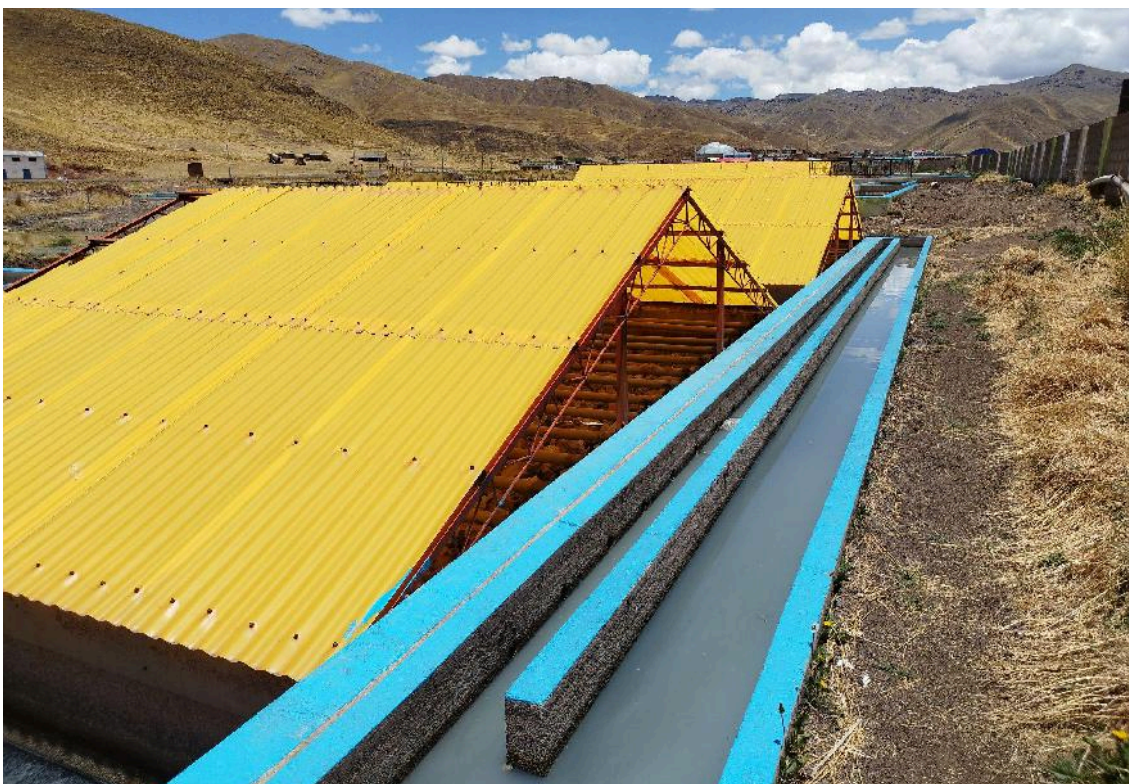
Figura 18. Vista de los desarenadores primario y secundario
