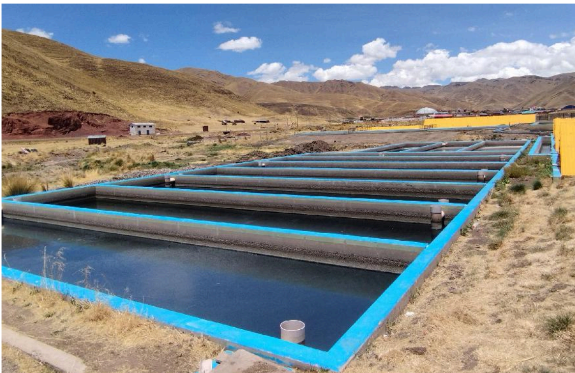
Figura 20. Vista de los sedimentadores
