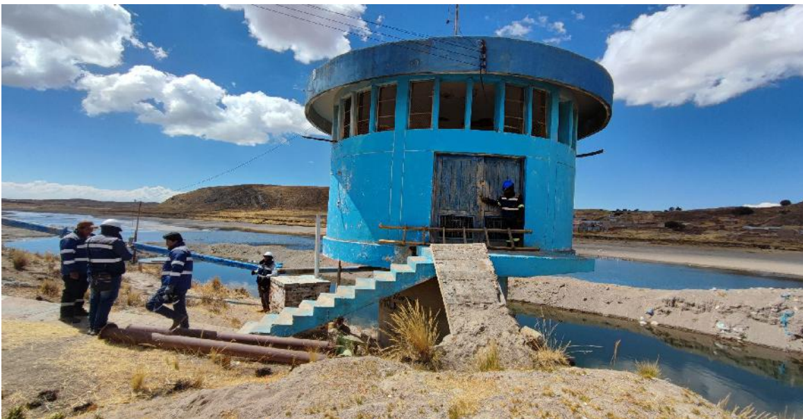
Figura 20: Inducción y retroalimentación sobre el uso de los EPPs a los operarios del trabajo.
