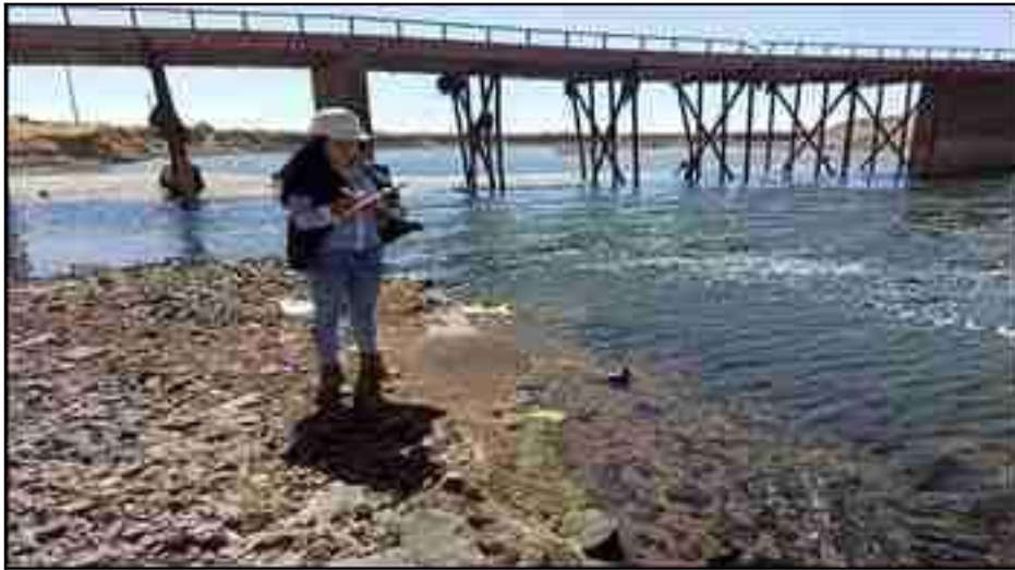
Figura 05: Identificando las zona de muestreo en la zona de Puente Independencia, río Coata.
