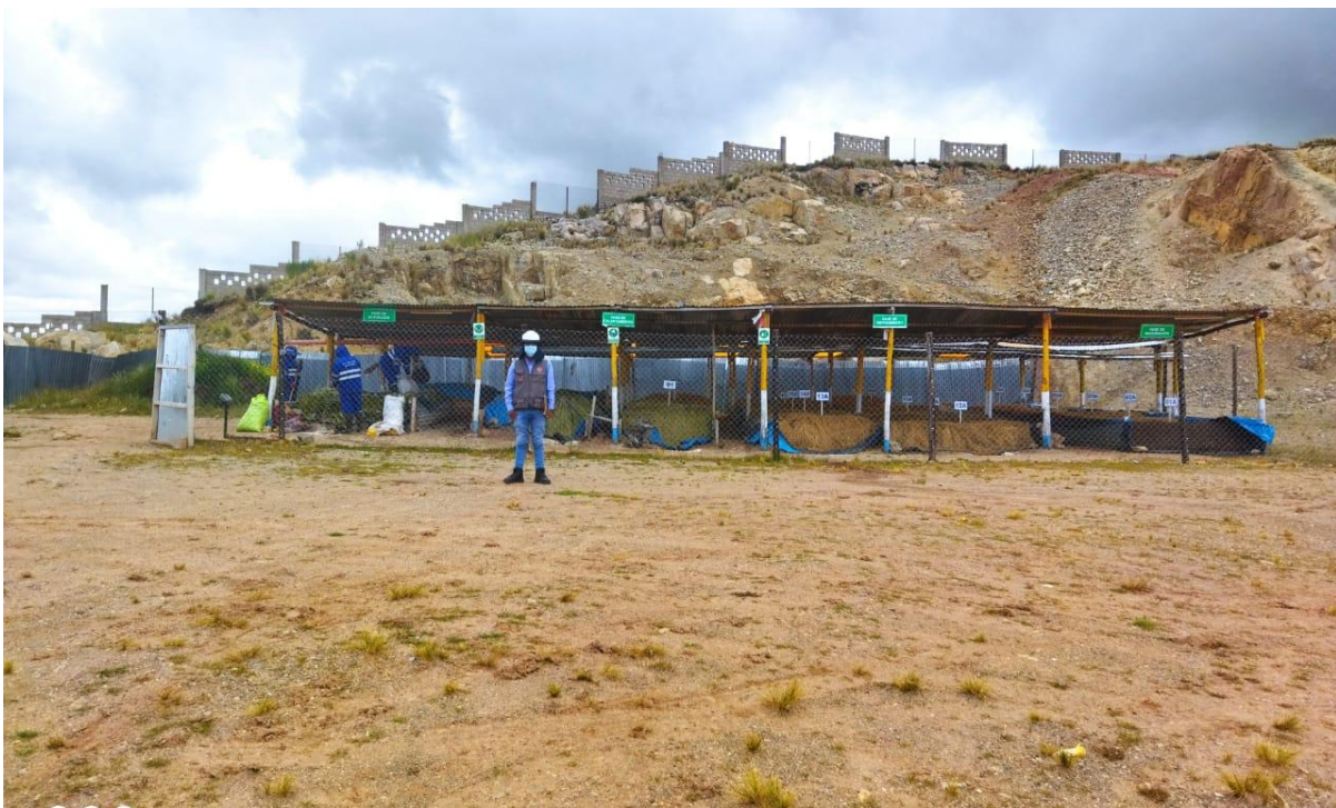
Anexo 5.6.- Vista panorámica del centro compostera de la municipalidad distrital de llave ubicado en botadero municipal.
