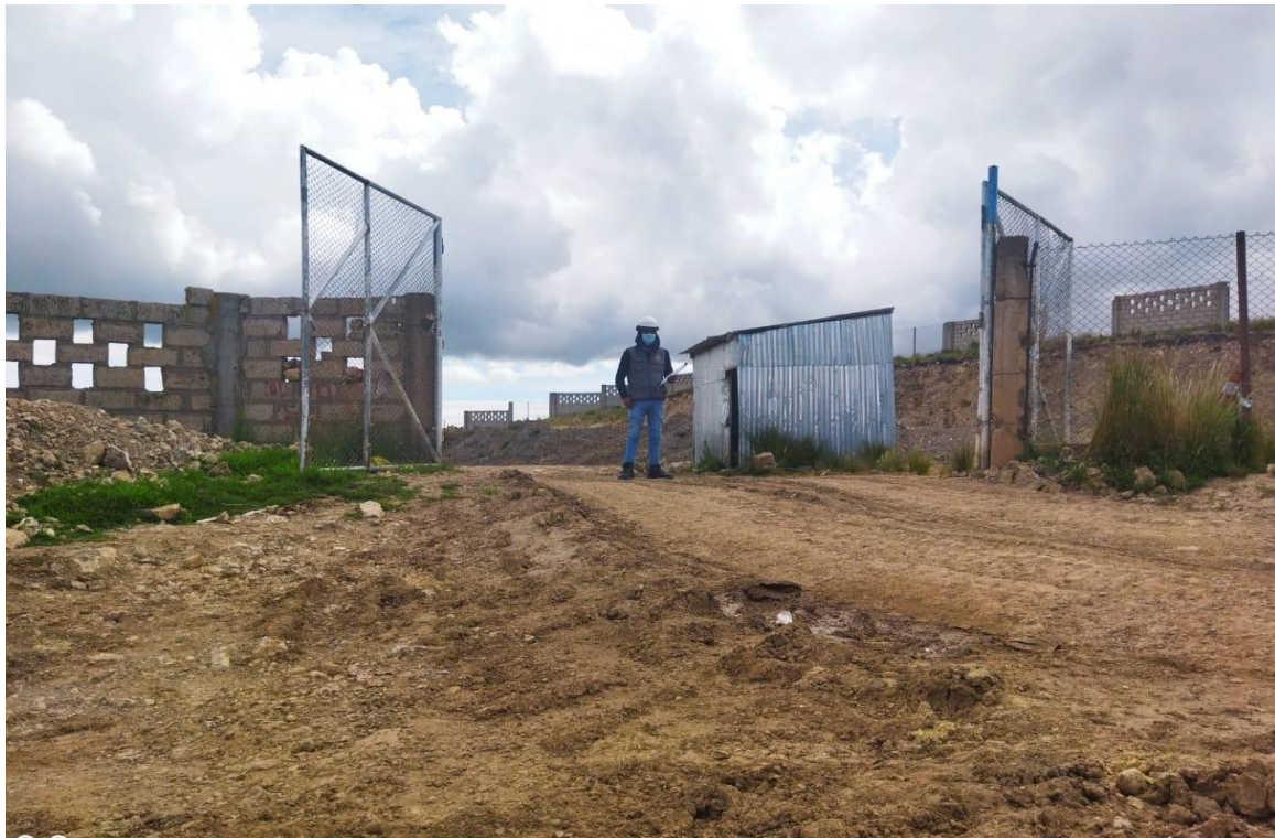
Anexo 5.1.- Entrada principal al botadero municipal del distrito de llave.
