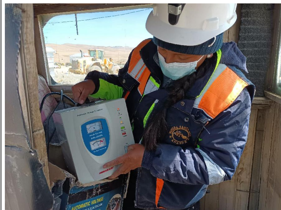
Figura 27: Instalación del estabilizador de energía.
